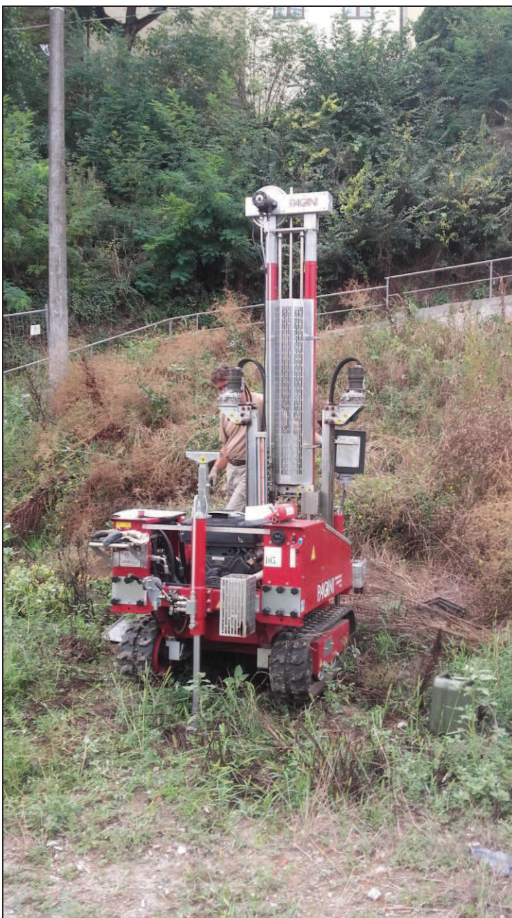
Prova penetrometrica 1 (base scarpata)
