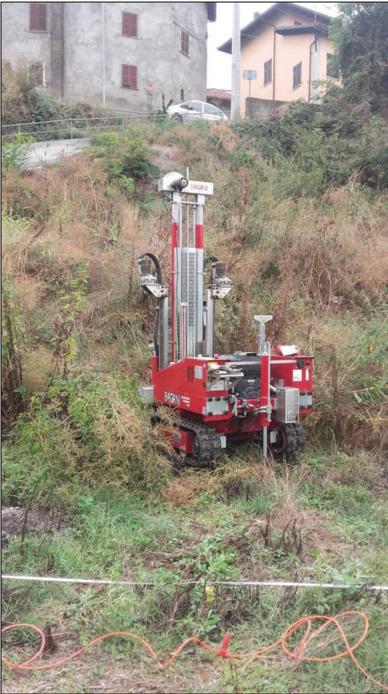
Prova penetrometrica 2 (base scarpata)
